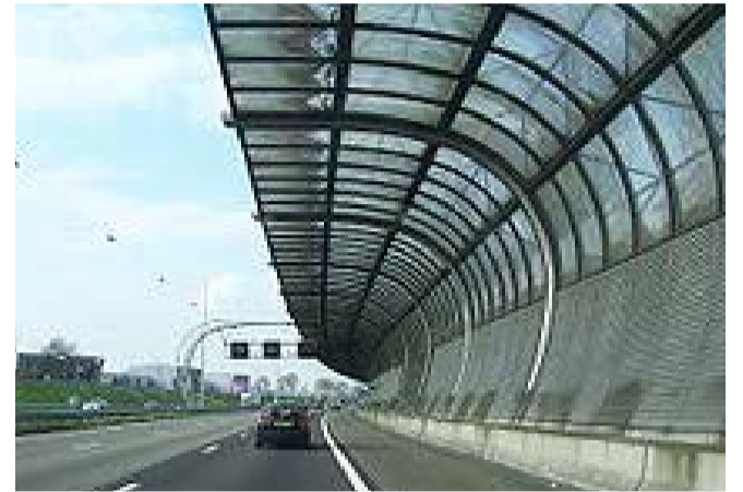
Geluidsscherm als luifel biedt mogelijkheden voor zonnepanelen
