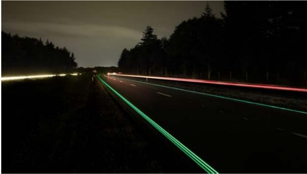
N329 Glowing Lines: Actieve markering door glow-in-the-dark belijning
