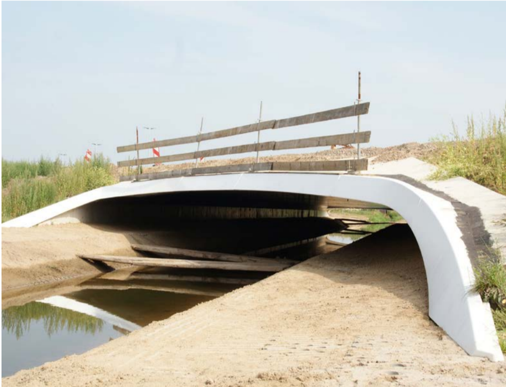
Referentie voor een brugdek over de waterlopen met doorvaarthoogte en faunapassages (N348 te Eefde)
